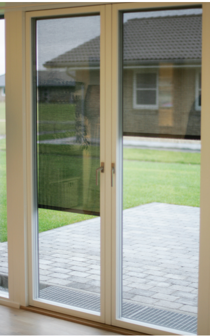
Udvendig solafskærmning som ikke tager udsynet fra boligen.
